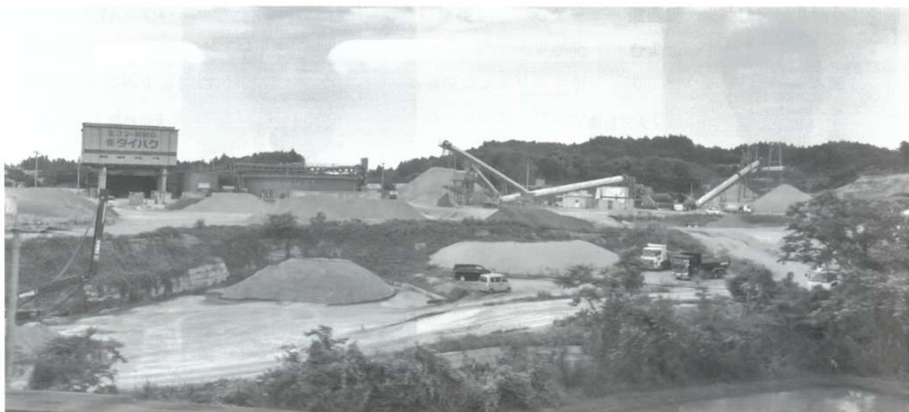
ストックヤードに繊維補強コンクリートを打設したタイハク社の洗砂工場
